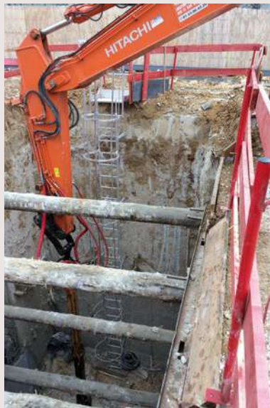
Échelle à crinoline utilisée dans le BTP pour la mise en place de fondations blindées
