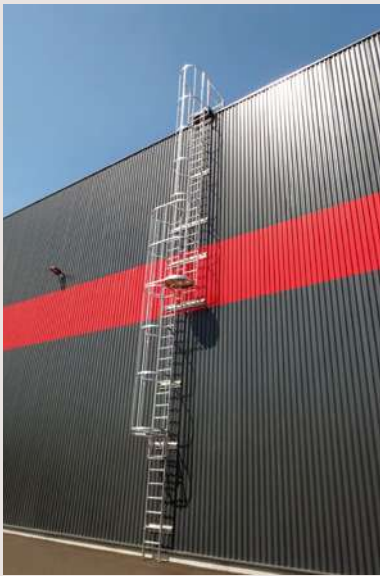
Crinoline sur bâtiment industriel
