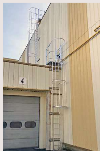
Échelle à crinoline sur bardage
