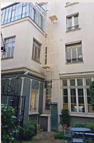
Échelle à crinoline sur immeuble
