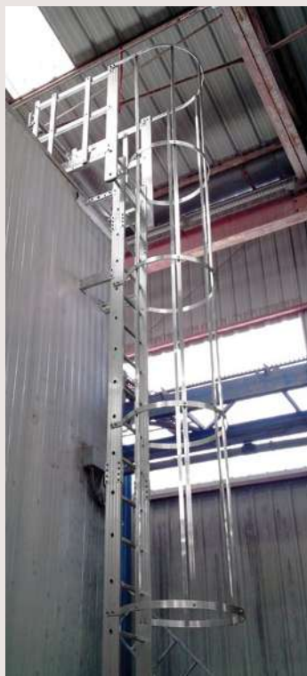
Échelle à crinoline intérieure avec montants renforcés 115 x 25 mm
