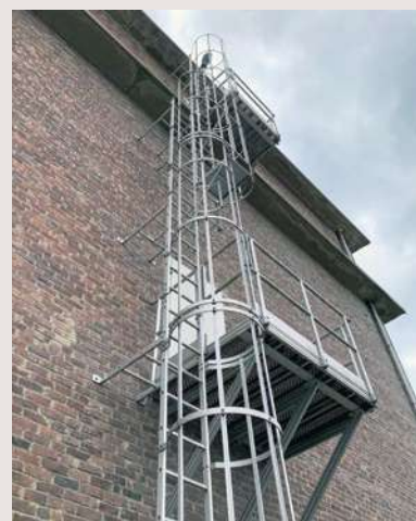
Échelle à crinoline avec palier latéral
