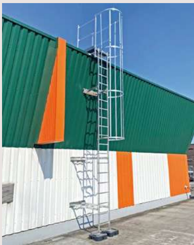
Échelles à crinoline avec fixation sur bardage
