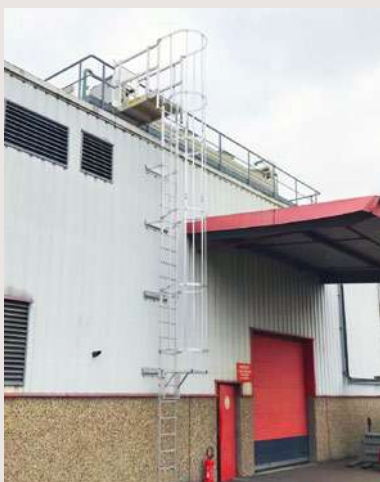
Échelle à crinoline - Hauteur 7,5 m
