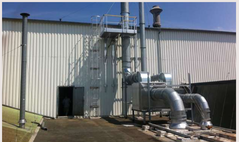
Échelle à crinoline et passerelle pour accès sur conduits d'extraction
